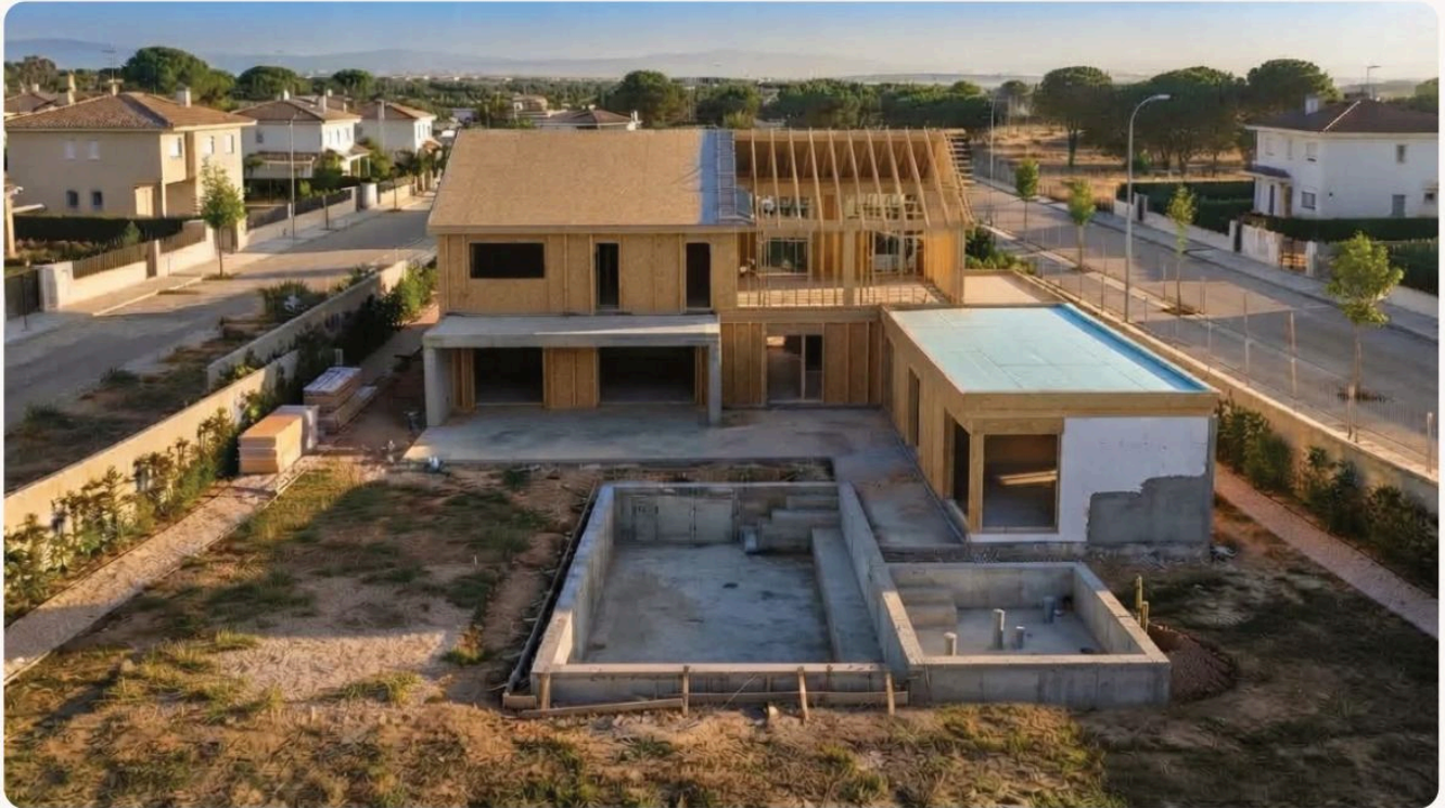
EJEMPLO DE VIVIENDA EN CONSTRUCCIÓN
